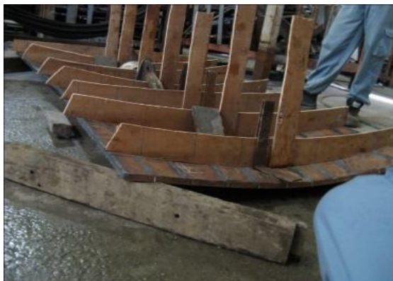
(d) Verify the transverse curvature of the K1 plate
